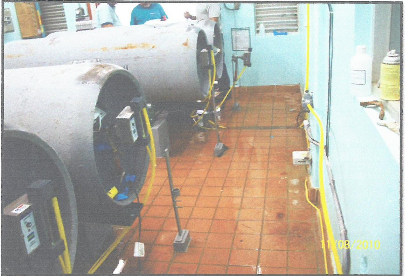
Aquí podemos apreciar la instalación del dosificador de cloro gas directo en el cilindro y además cuenta con un sistema de cierre automático en caso de fugas. El uso de mangueras en vez de tuberías vulnerables a la corrosión. Ventilación adecuada del área de instalación y manejo de los cilindros.
