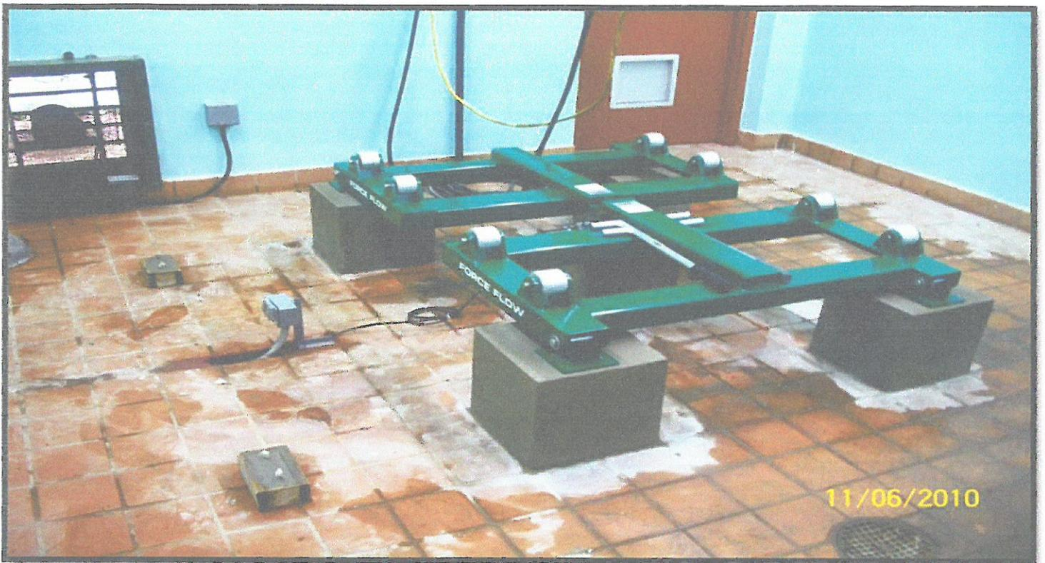
Balanzas para el control del contenido de cloro de los cilindros.
