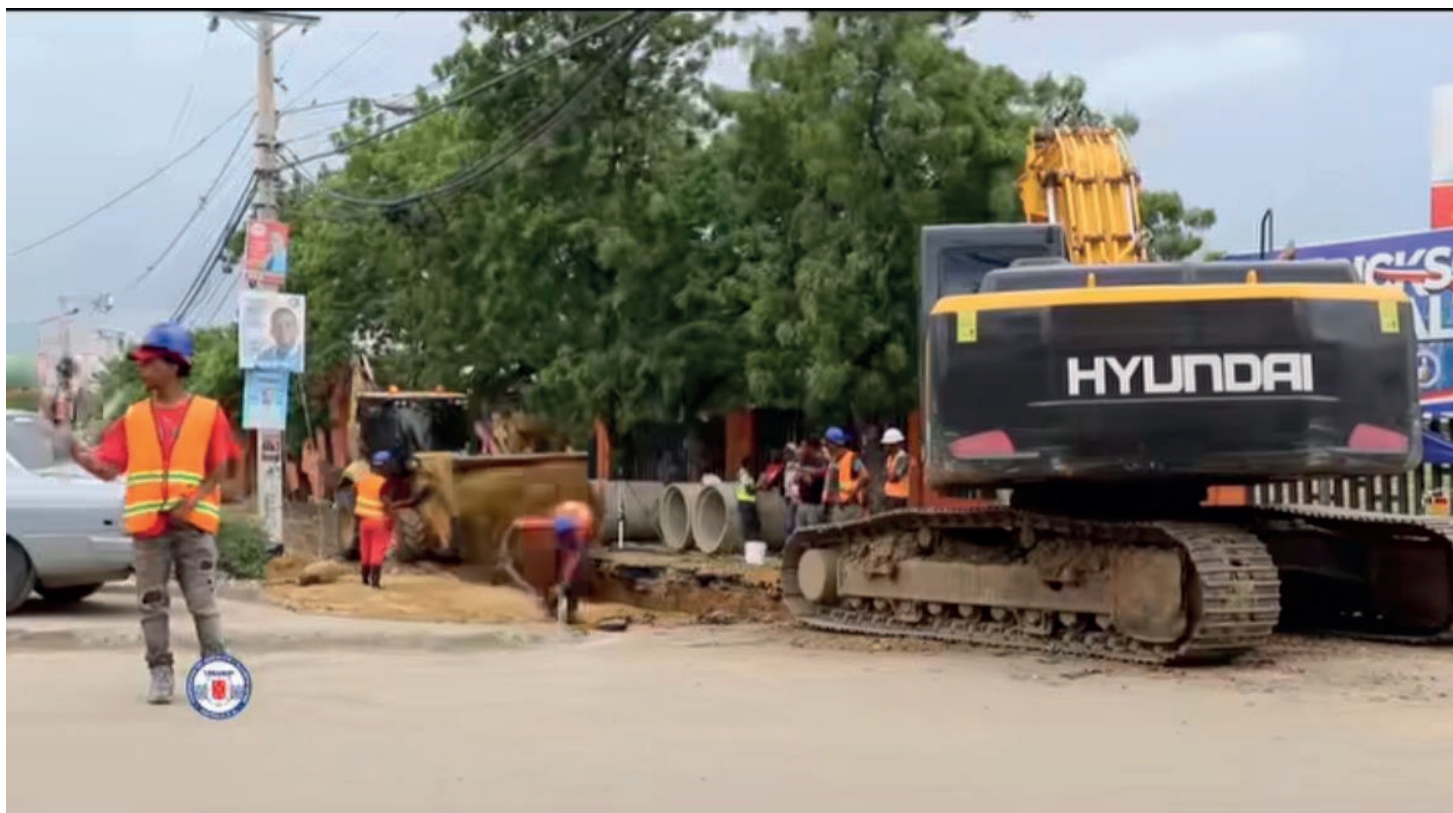
Avance de los trabajos del colector de aguas residuales Calle Sergio Hernández esq. 30 Caballeros en Cienfuegos.
