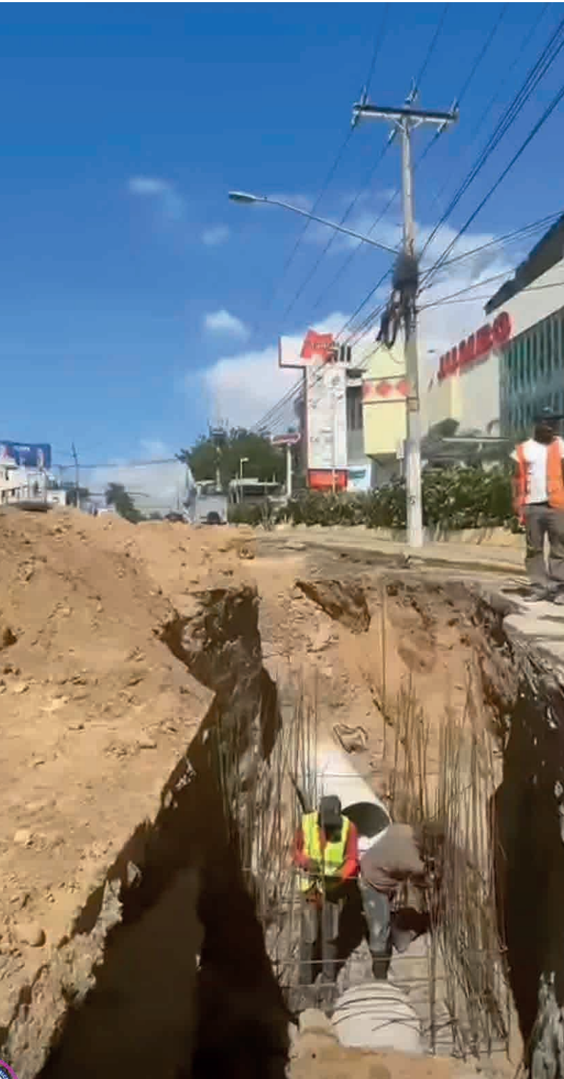
Avanzan trabajos de ampliación colector de aguas residuales en ave. 27 de Febrero esq. Imbert.
