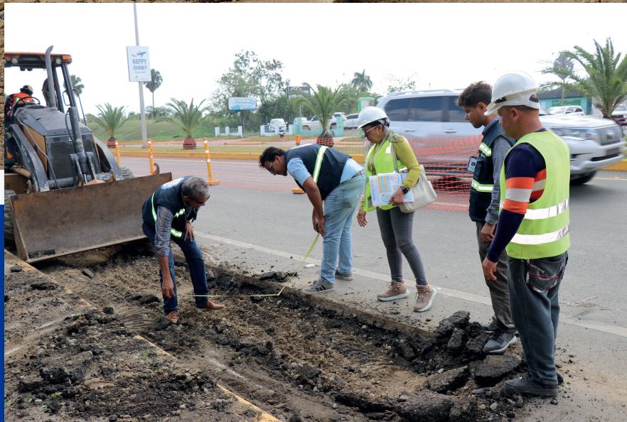
Avanzan los trabajos de construcción de la línea de impulsión de 24 pulgadas y la línea de distribución de agua potable en Puñal y zonas aledañas.
