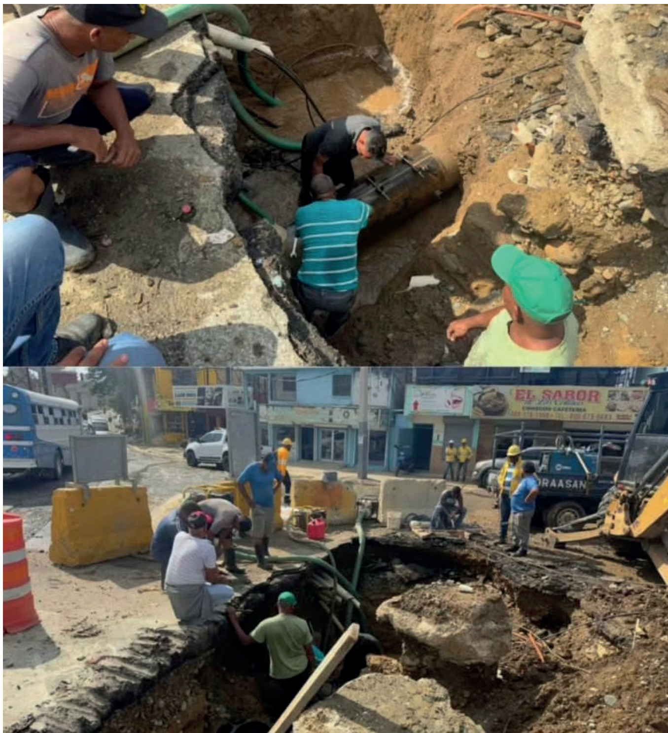
Nuestro equipo de Mantenimiento de Redes, agilizó los trabajos de corrección de una avería que se produjo en la línea de 18 pulgadas en la avenida 27 de Febrero, esquina Cuesta Colorada.
